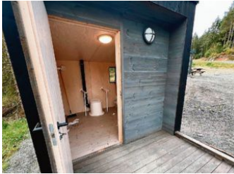
TOALETT VED LYSØYPA: Tilrettelagt også for rullende.
